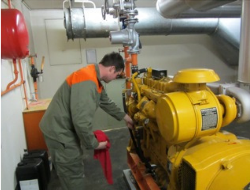
Wartungsarbeiten am Notstromgenerator
