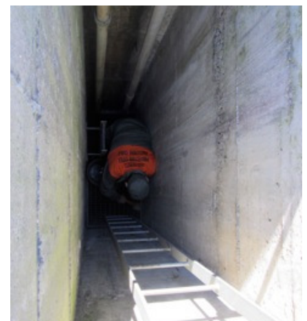
Abstieg in den Notschacht
